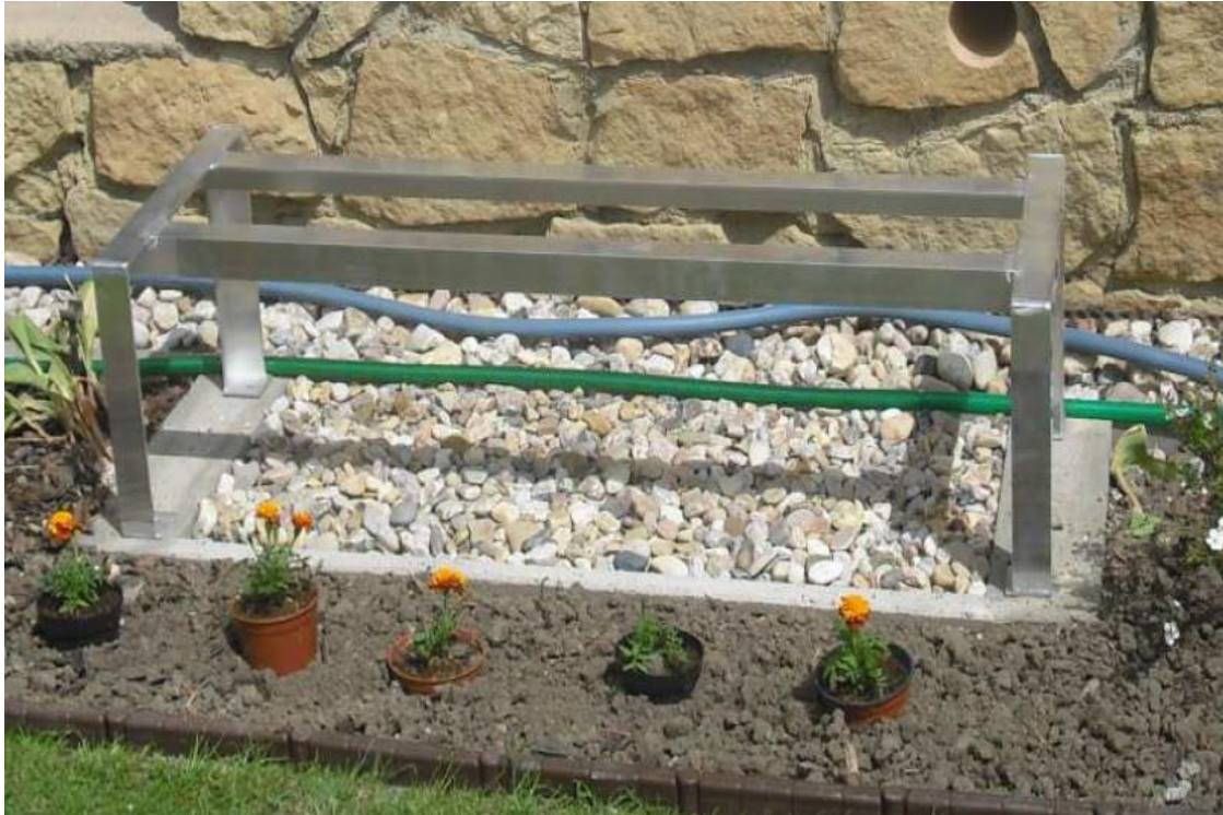
Obrázok 5: Ukážka prevedenia základu pre tepelné čerpadlo
